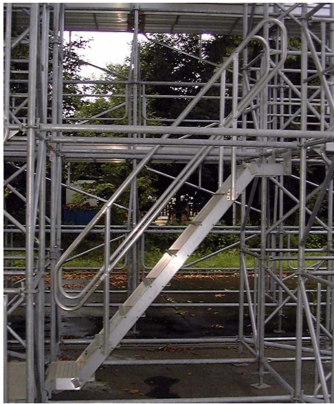
手すり及び中さんを設置した 昇降階段の例
