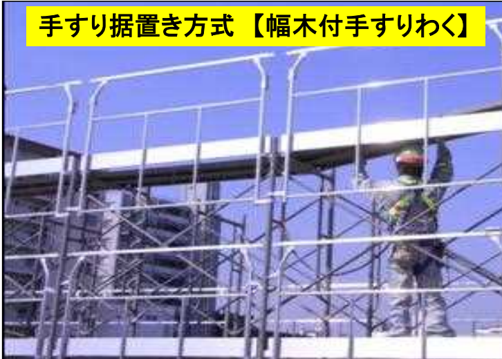
手すり先行専用足場方式【手すりわくタイプ】
