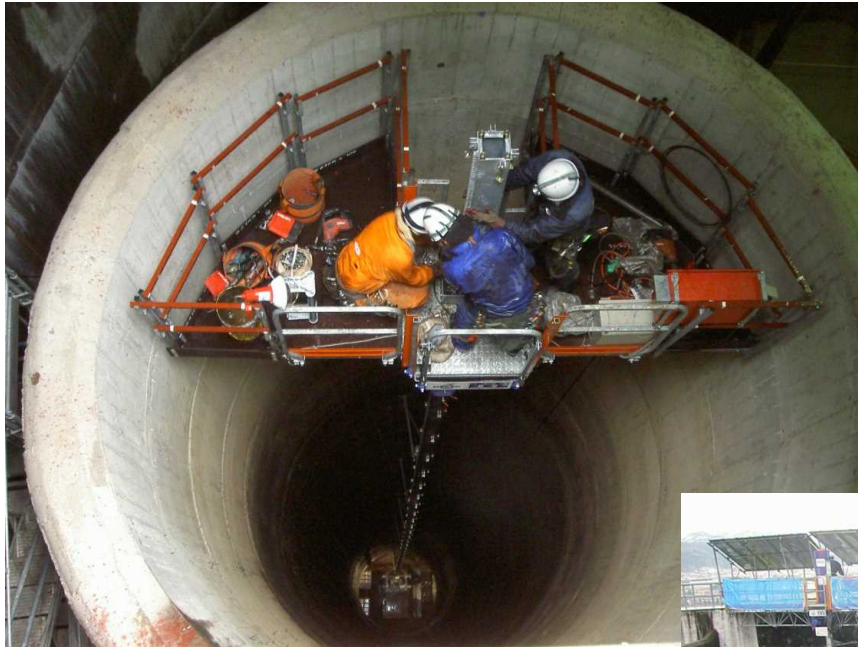
ライザー管補修工事
