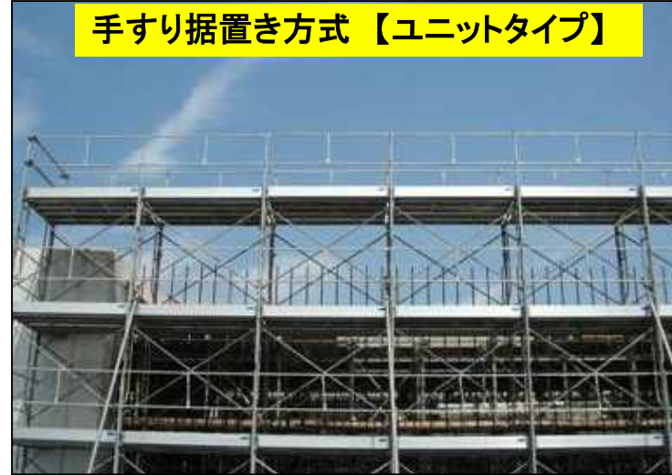
手すり先行専用足場方式【ユニットタイプ】
