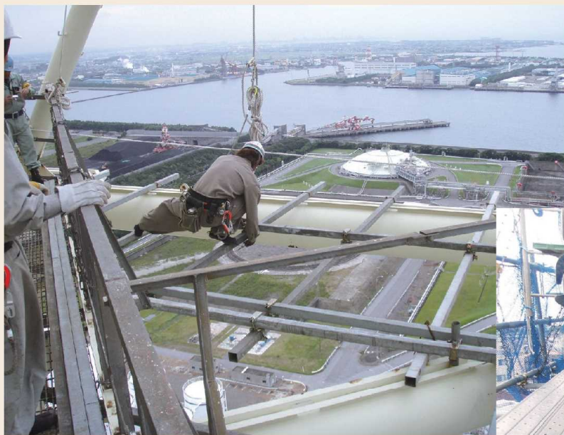
在来工法と完成した足場状態
